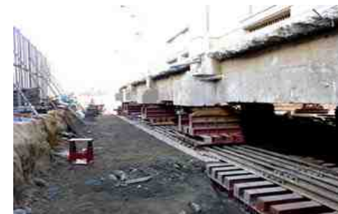
4 レールの上をころを置き転がっていきます。
