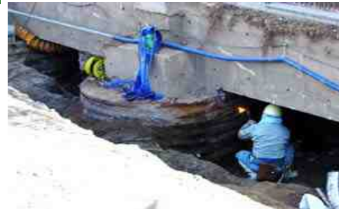
2 建物は地震などがあっても壊れないように、頑丈な基礎があります。その上に建物を載せるような形で建てています。ですから児童館の基礎の部分の掘って、柱と建物を離さないと建物は動きませんね。(平成16年12月上旬)
